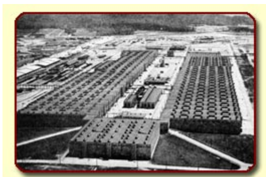
Rys. 5.7. Zakłady dyfuzji gazowej K-25 w Oak Ridge. Ta czteropiętrowa instalacja miała prawie 800 m długości i zajmowała łączną powierzchnię niemal 180 000 m 2
